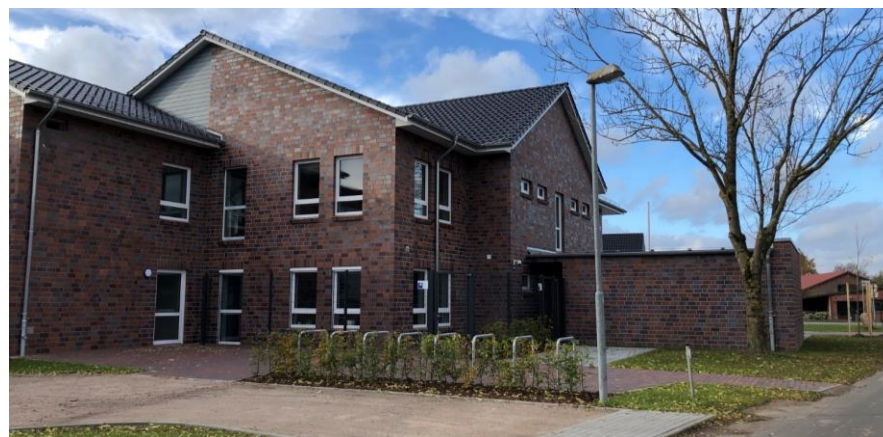
Abbildung 56: Blick auf den Anbau von der Segeberger Straße (cima 2021)
