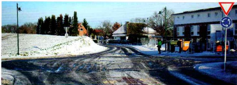
Der kleine Kreisel am Rodelberg wird sehr oft von Fahrzeugen „überfahren“, die keinen Versuch machen, auf der Fahrbahn zu bleiben. Es geht dann mit gleicher Geschwindigkeit geradeaus. Dadurch ergeben sich Situationen, bei denen insbesondere Fußgänger und Radfahrer gefährdet sind.
