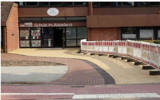
Der neu gestaltete Zugang zur Schule ist in Arbeit. Es wurden die gleichen Pflastersteine wie auf dem Schulhof verwendet. Damit ergibt sich ein einheitliches Bild und zudem sind sämtliche Stufen im Zugangsbereich durch das eingebaute Gefälle entfallen.
