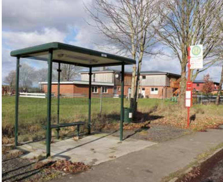
beleuchteter Fahrgastunterstand an der Bushaltestelle
