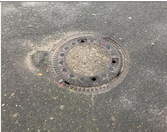
Oberflächenzufluss in Schacht 2451011 / Öffnungen z.T. bereits verschlossen
