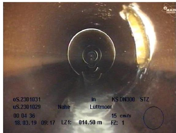
Bild 4-6: SW 2301031, klarer Zufluss aus GAK fließend
