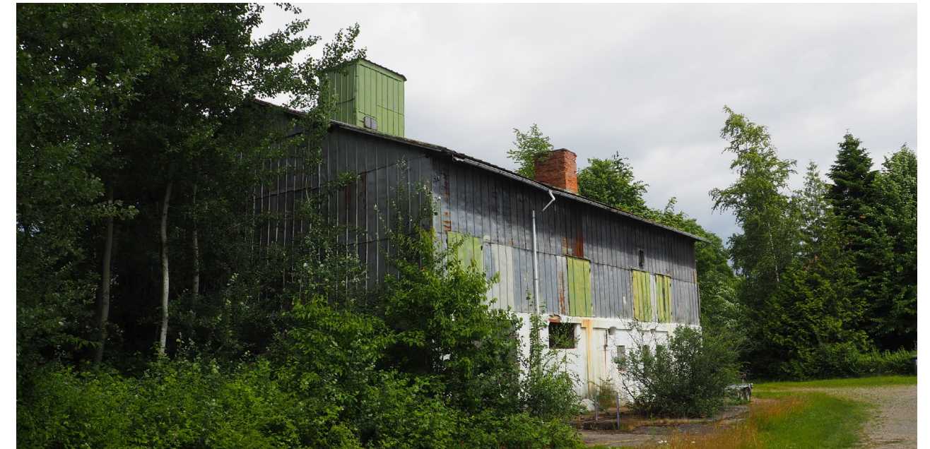
Während am Ortsrand und im Außenbereich neue Wohngebiete entstehen, verfällt alte Bausubstanz. (Foto: Merlin Michaelis, BUND SH)
