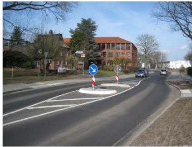
Neu hergestellter Querungsbereich über die K104 in Alveslohe
