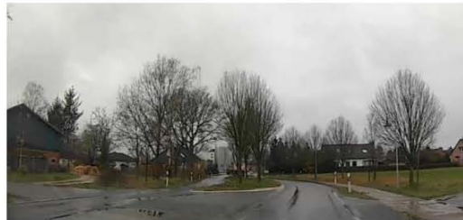
L232 Ortseingang Struvenhütten
