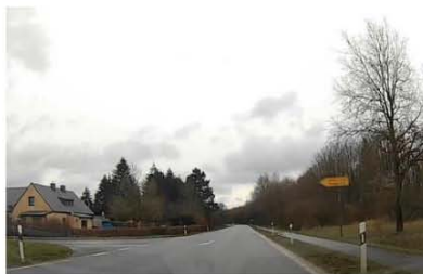
Fehlende Querung über L320 bei Nützen
