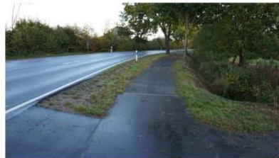
Nach der Straßensanierung neu hergestelltem Radweg mit wassergebundener Decke an der L80 westlich von Oering Unten: Übergang vom asphaltierten Bestandsradweg
